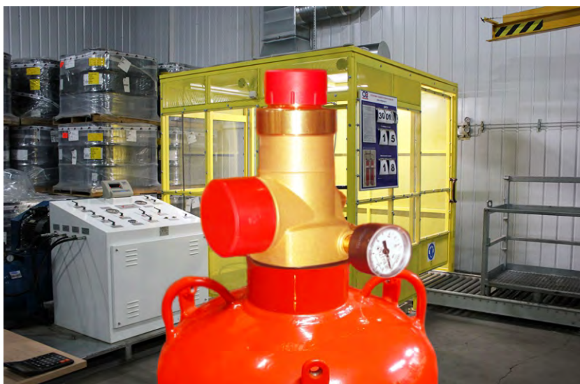
Запорно-пусковые устройства (ЗПУ)
